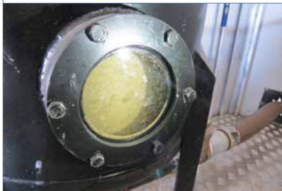
Foto 90. Formação da camada de diatomácea concluída
