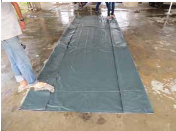
Foto 136. Continue dobrando e limpando no sentido do centro
