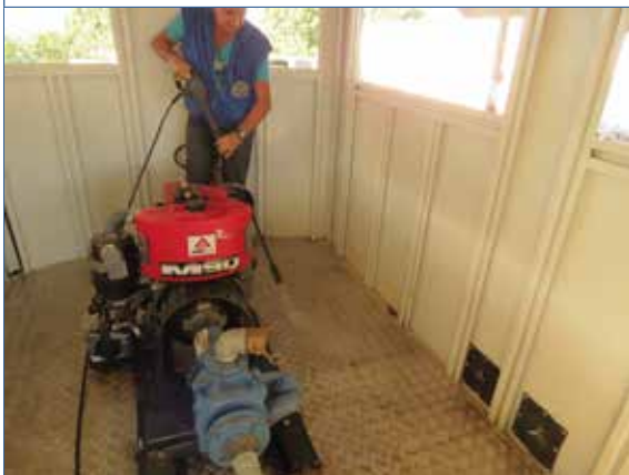
Foto 140. Procedimento de limpeza dos trailers
