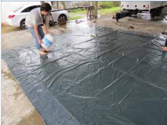
Foto 134. Procedimentos de limpeza da lona de proteção do tanque
