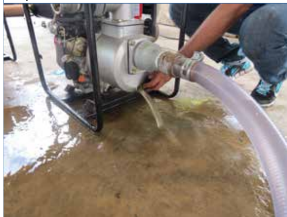
Foto 49. Proceder a limpeza interna, e fechar o dispositivo
