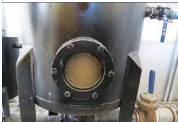
Foto 89. Formação da camada de diatomácea em volta das velas do filtro
