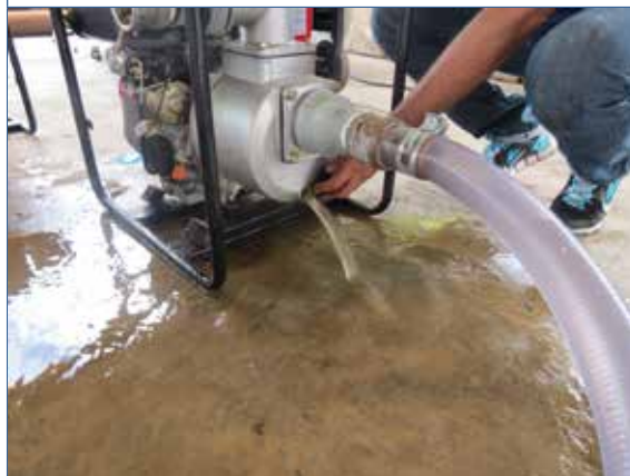
Foto 141. Desativando a motobomba de água
