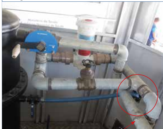
Abertura para a mangueira de despressurização
