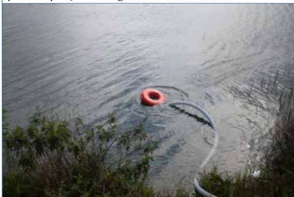
Foto 42. Posicionamento ideal do pé-de-crivo para captação de água
