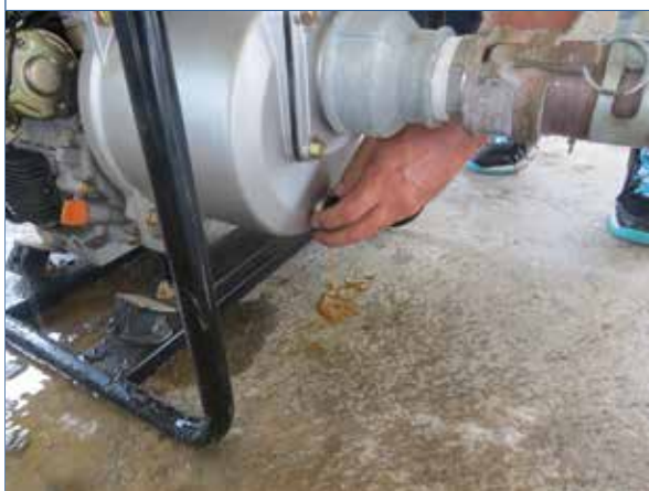
Foto 47. Dispositivo de vazão de água do interior
