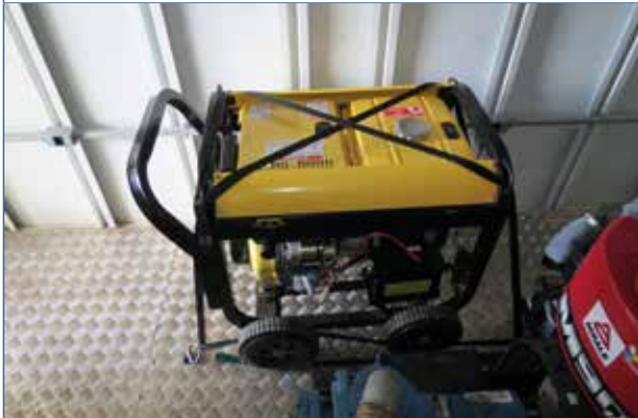
Foto 1. Fixação do gerador
