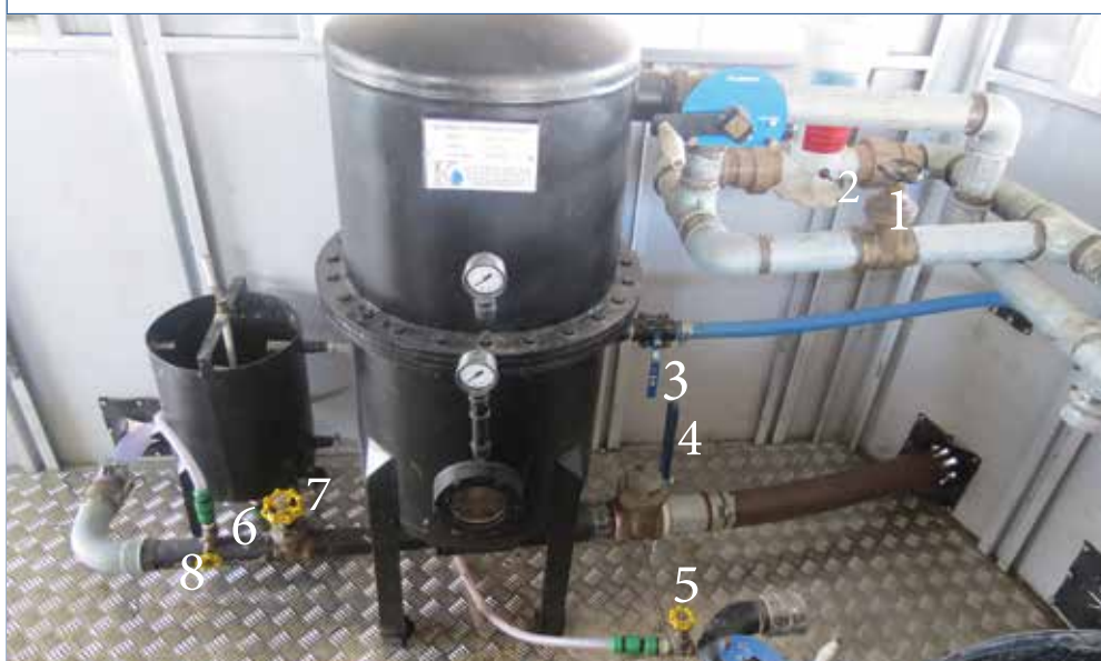
Foto 104. Repetindo o processo de limpeza (lavagem) das velas e do filtro
