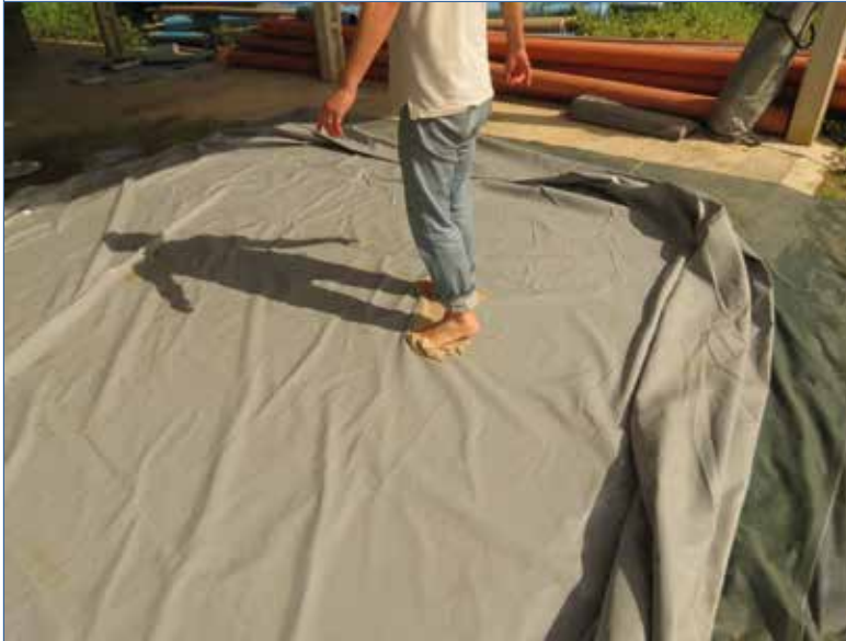
Foto 126. Secagem dos tanques
