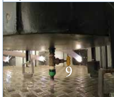
Foto 68. Registro abaixo do tanque
