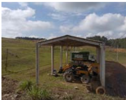
Figura 21 – Equipamentos de apoio à operação do aterro.
