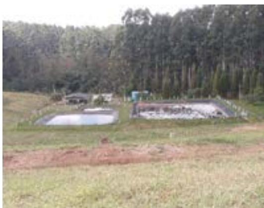
Figura 20 – Central de tratamento de percolato do aterro.
