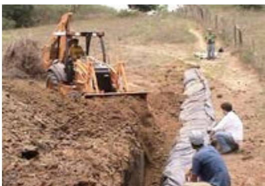
Figura 9 – Reaterro da vala da barragem com uso de retroescavadeira.
