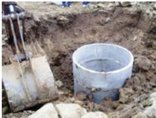
Figura 10 – Instalação de poço amazonas a montante da barragem.
