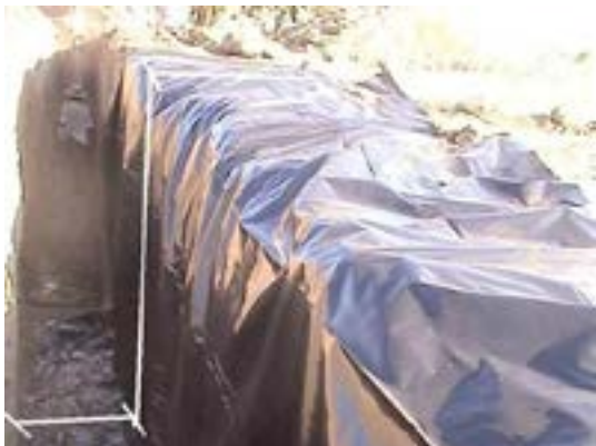
Figura 8 – Fixação da lona de PVC 200 micras na vala para barramento do escoamento subsuperficial.
