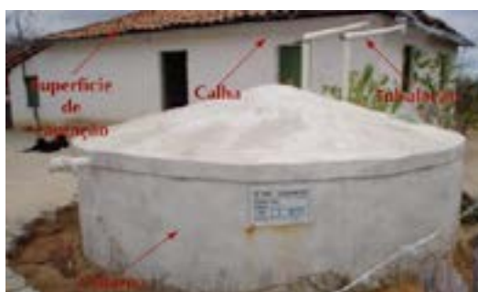
Figura 1 – O sistema de captação de água de chuva em um domicílio do semiárido brasileiro. Fonte: Pádua et al. (2010).
