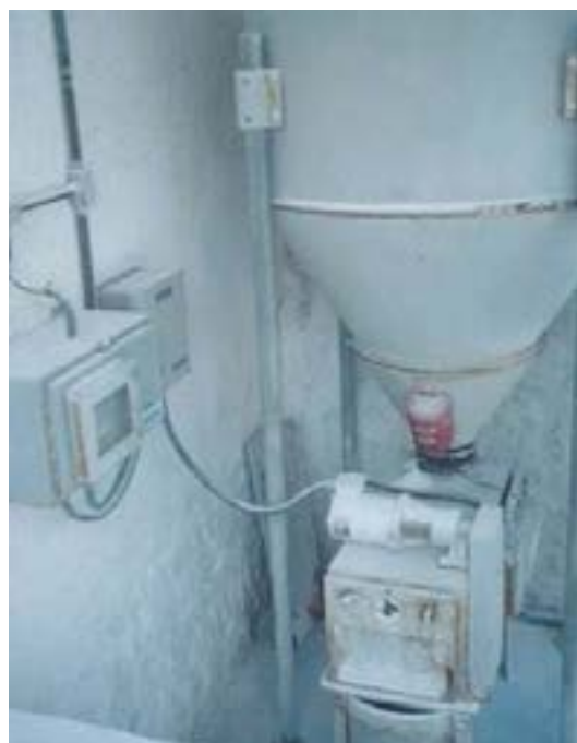
Figura 28 – Fluoretação da água com uso de dosador de flúor.
