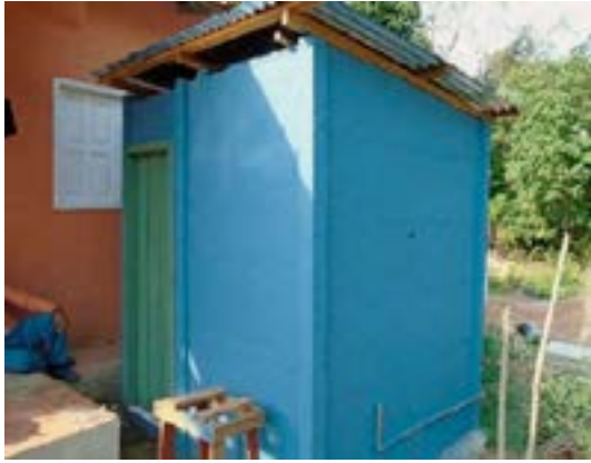
Figura 53 – ISD de placas pré-moldadas de concreto.
