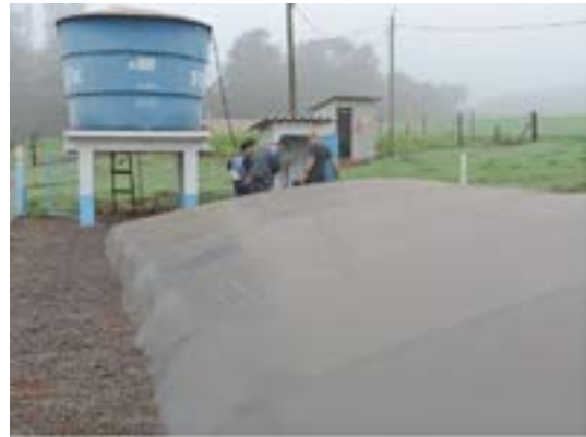
Figura 48 – Cisternas Coletoras de Água da Chuva com capacidade de 500m³ de água em uma propriedade rural localizada em Linha Ajuricaba.
