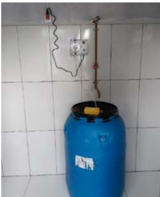
Figura 27 – Desinfecção da água com uso de bomba dosadora de cloro em comunidade rural do estado da Bahia.
