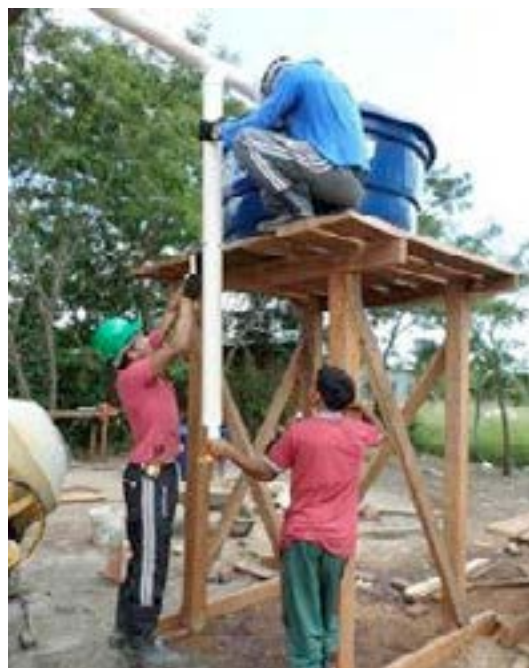
Figura 51 – Instalação do tubo de PVC para descarte da 1ª água.
