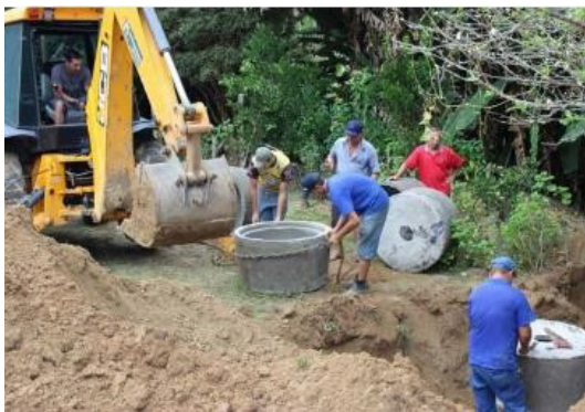
Figura 22 – Instalação de módulos de fossas sépticas em área rural de São Ludgero.
