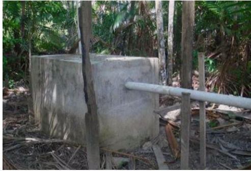
Figura 35 – Fossa construída em terreno de várzea.
