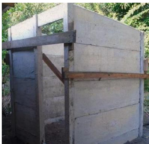
Figura 28 – ISD de placas pré-moldadas em construção.
