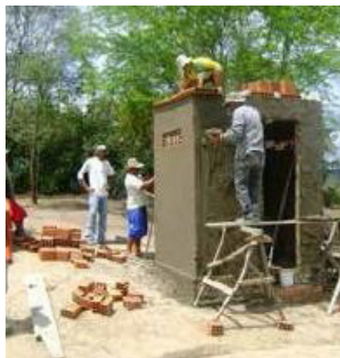
Figura 38 – Mutirão de construção dos banheiros. Fonte: Cepagro (2013).
