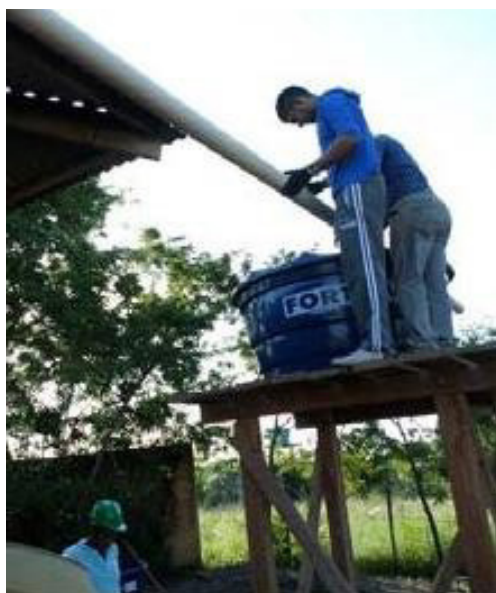
Figura 26 – Instalação da calha no telhado com tubo PVC 100 mm.
