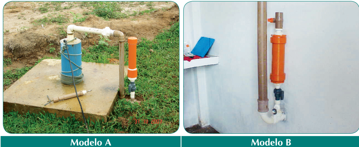
Figura 4 – Instalação do clorador simplificado.
