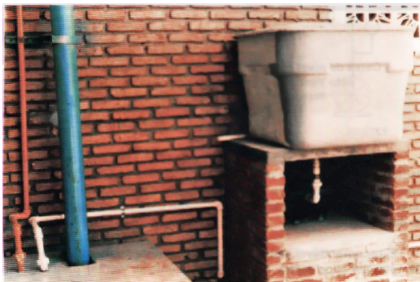
Figura V – Dosador simples por gravidade auxiliado por água sob pressão para transporte e aplicação
