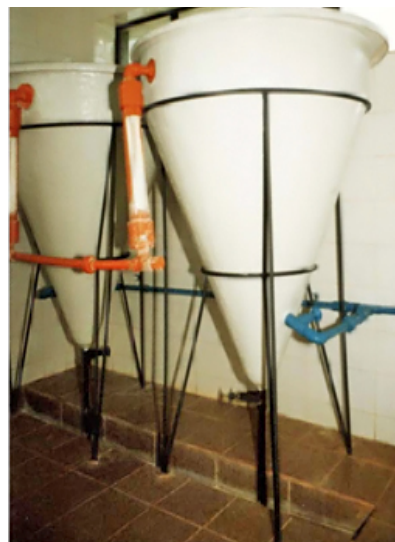
Figura VII – Cone de fluoretação
