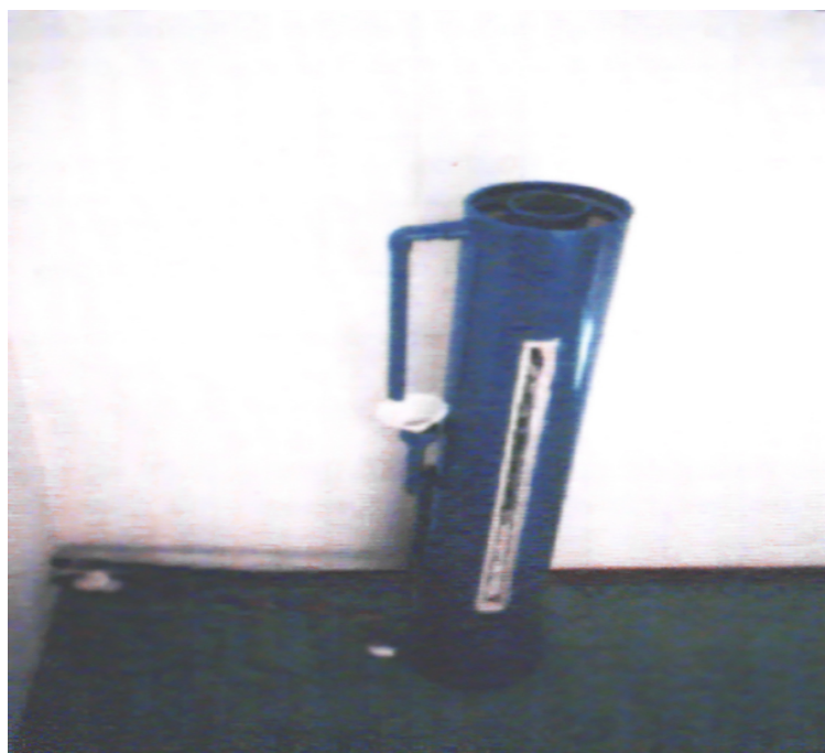
Figura VIII – Tubulação de saturação
