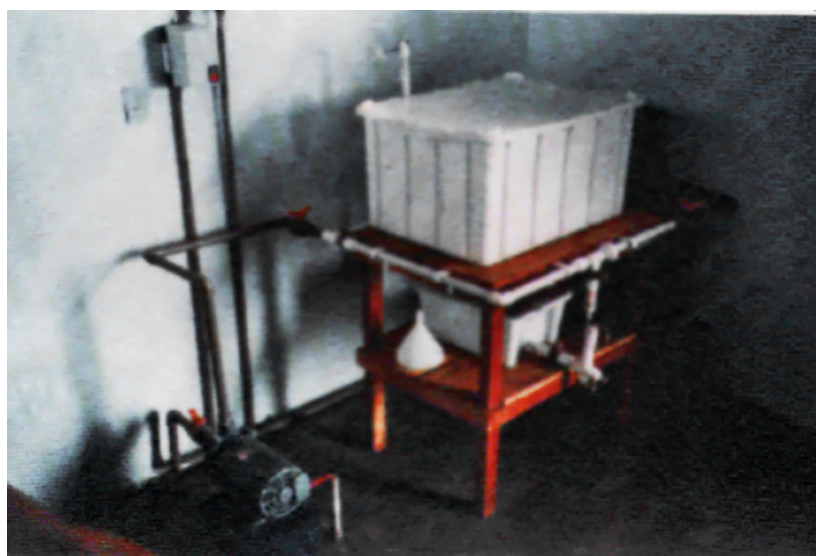
Figura VI – Dosador de nível constante sob pressão
