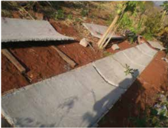
Figura 8 – Concretagem das laterais da cisterna Fonte: Teixeira et al. (2011)
