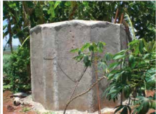
Figura 9 – Cisterna montada Fonte: Teixeira et al. (2011)
