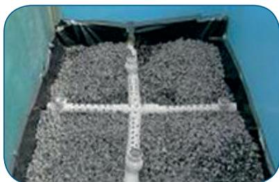
Este sistema é instalado no fundo do filtro, utilizando-se tubulações perfuradas na parte superior. O diâmetro das tubulações deve variar em função da dimensão do sistema, podendo ser utilizados diâmetros de 75 a 200 mm. Não se recomenda a utilização de diâmetros menores para evitar a obstrução do fluxo de saída do líquido percolado.
