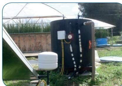
A tampa do tanque de aquecimento foi confeccionada com uma chapa metálica, malha de fibra de vidro e placas de madeira. A chapa de ferro é a parte superior da tampa, sendo que logo abaixo se encontra as placas de madeira revestidas na parte inferior com a malha de fibra de vidro. A principal função da madeira é servir de isolante térmico, e os outros materiais apoiam na sustentação da peça. A espessura da tampa é de 10 cm.
