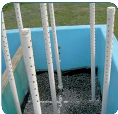
Um sistema de ventilação natural deve ser instalado nos filtros para melhorar as condições de oxigenação, permitindo o desenvolvimento de micro-organismos aeróbios para a decomposição do lodo e líquido percolado. O sistema de ventilação fica conectado com o sistema de drenagem do filtro, devendo ser elevado pelo menos um metro acima da altura das macrófitas.
