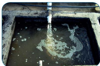
Para permitir o tratamento do líquido percolado e o desaguamento do lodo deve ser adotado um tempo de detenção hidráulica mínimo de seis dias, como descrito anteriormente. Em termos práticos, a saída do FP deve permanecer fechada por seis dias, e aberta na sequência por 24 horas, permitindo que todo o líquido seja escoado do leito.
