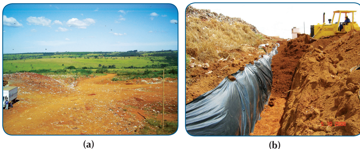
Figura 27 – Área de aterro controlado (lixão) no ano de 2004 (a); detalhe da implantação da barreira hidrogeológica (b).
