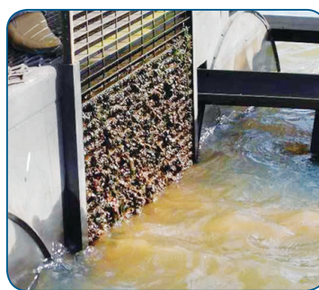
Figura 6 – Mexilhão dourado: (a) formas do mexilhão; (b) incrustação na captação da ETA Vila C do reservatório de Itaipu.
