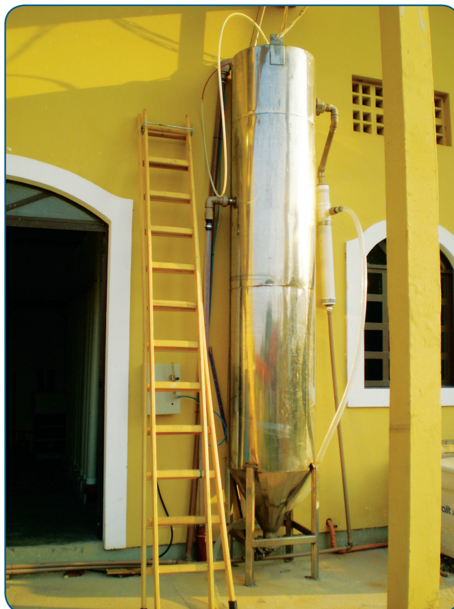
Figura 10 – Construção do filtro autolimpante.
