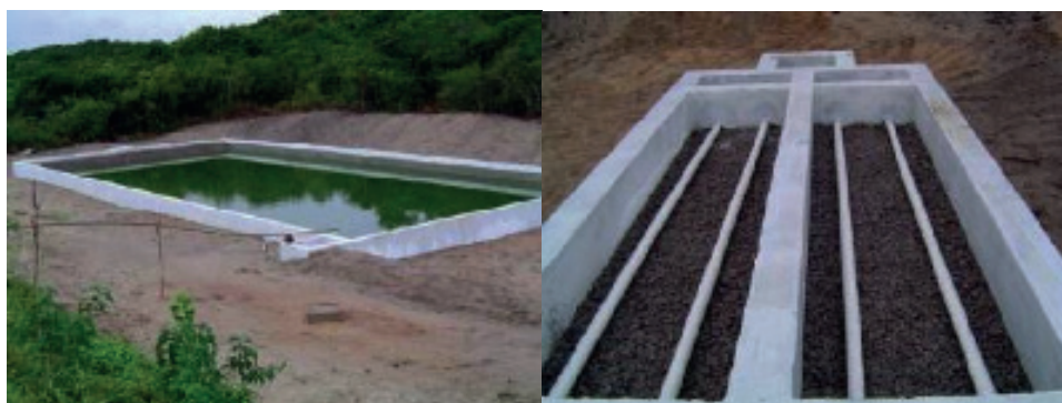
Figura 22 – Vista do wetland (esquerda) e filtro biológico (direita) implantados na Estação de Tratamento de Esgoto de Ponta Negra.
