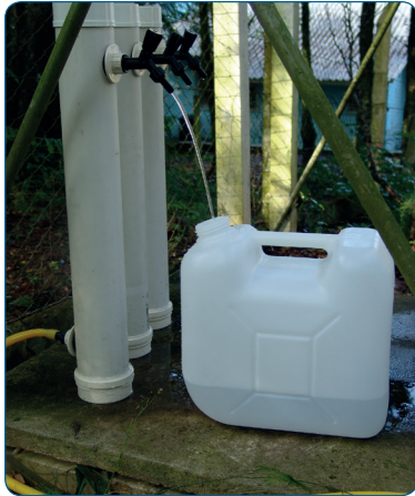
Figura 7 – Filtro para desfluoretação: Instalação.
