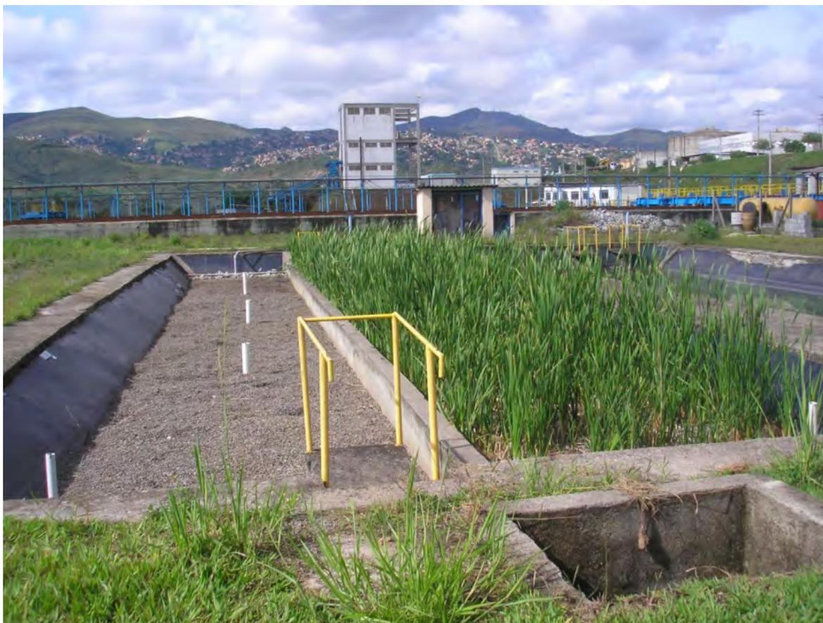
**Figura 2** - Vista das *wetlands* de escoamento horizontal subsuperficial (plantada e não plantada)
