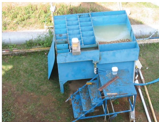
Figura 5 – ETA piloto onde foram desenvolvidos os experimentos, ao lado da ETA Duas Bocas, em campo, próximo à barragem
