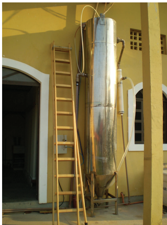
Figura 10 – Construção do filtro autolimpante
