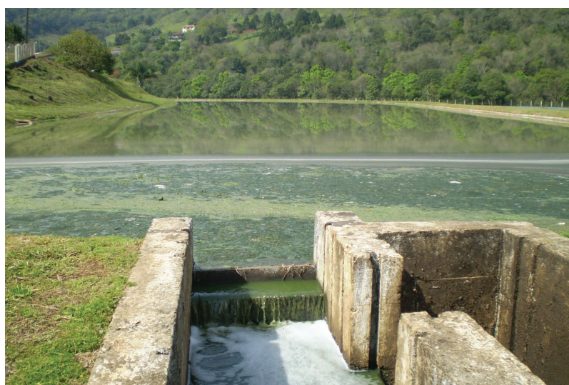
Figura 16 –Lagoa de estabilização
