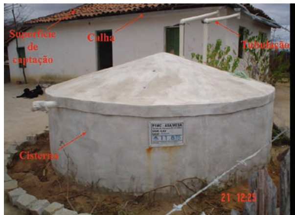
Figura 9 – Cisterna de placas para captação da água de chuva
