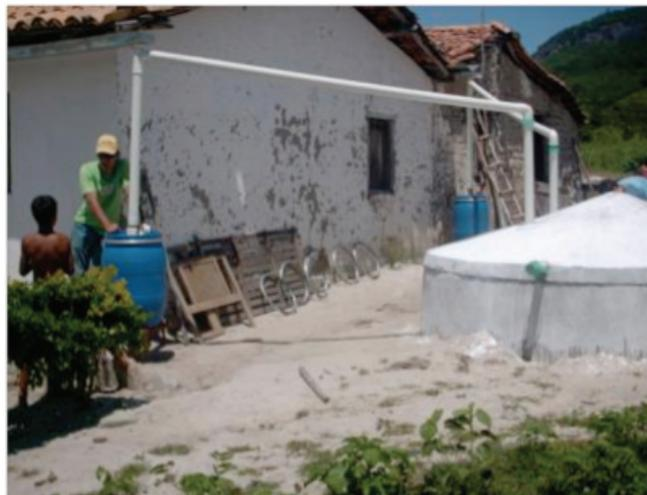
Figura 13 - Dispositivos instalados numa cisterna com telhado de duas caídas
