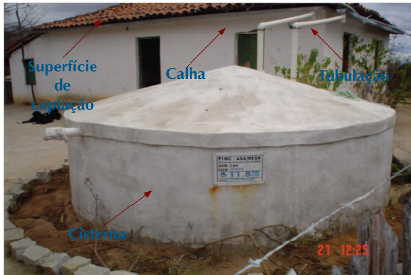
Figura 1 – Sistema de captação de água de chuva
