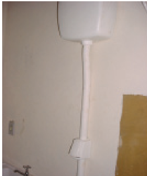
Figura 4.8 – Caixa de descarga alta com botão
