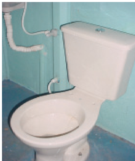
Figura 4.10 – Bacia sanitária com caixa e sistema dual de descarga (3 litros e 6 litros)
