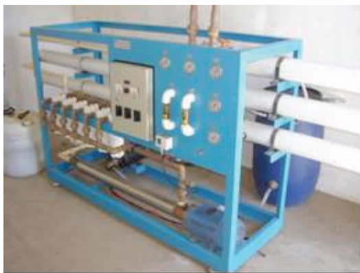
Figura 5 – Dessalinizador de Minuim: (a) vista do equipamento (b) moradores coletando água em baldes no chafariz
