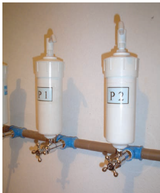
Figura 5 – Filtros do tipo gravidade: reservatórios e elementos filtrante (vela)
