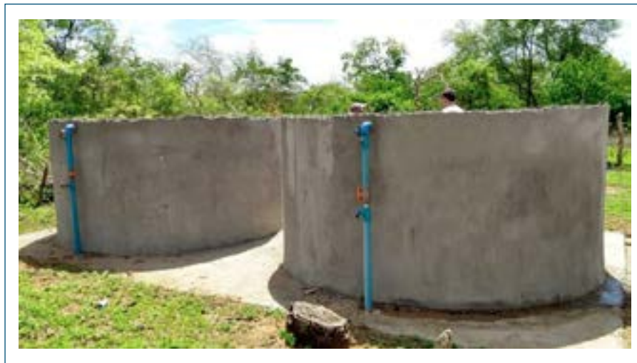
Figura 4 – Decantadores do sistema de tratamento de Lagedo (sem cobertura).
