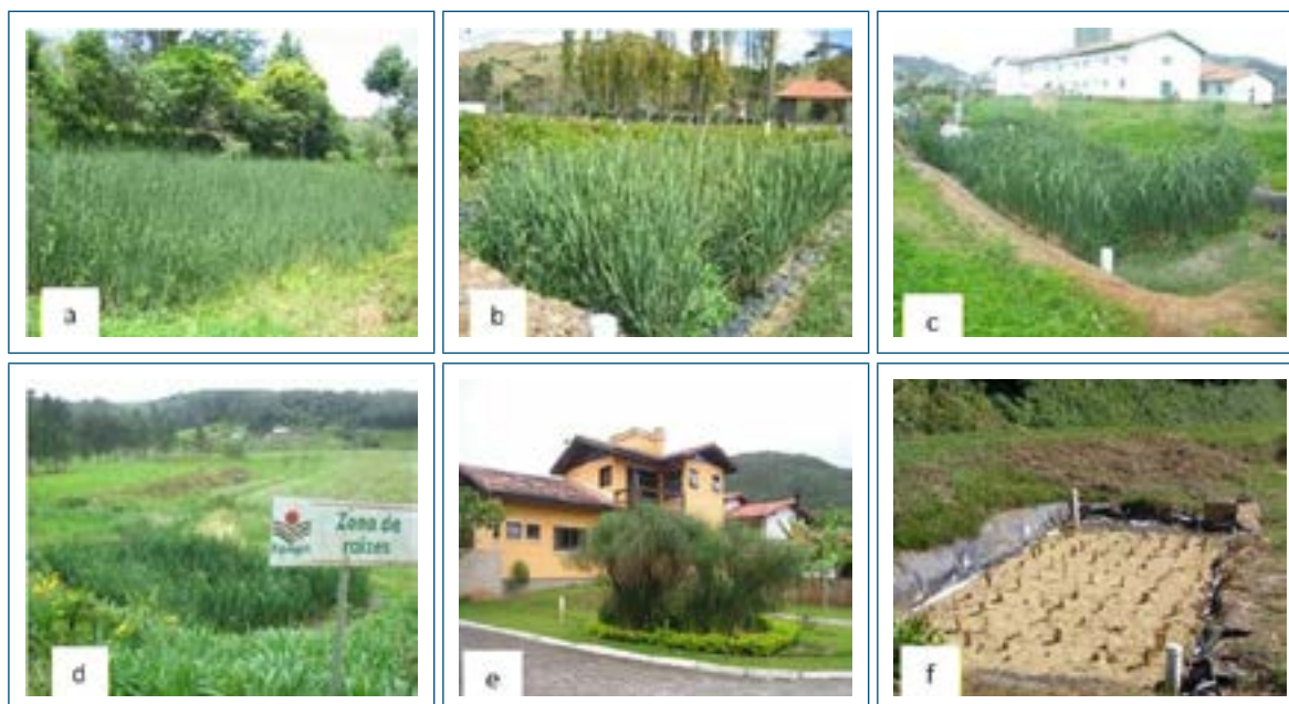
Figura 1 – Wetlands construídos horizontais implantados em diferentes cidades de Santa Catarina. (a) Agronômica; (b) São Joaquim; (c) Tubarão; (d) Videira; (e) Florianópolis; (f) Videira.
