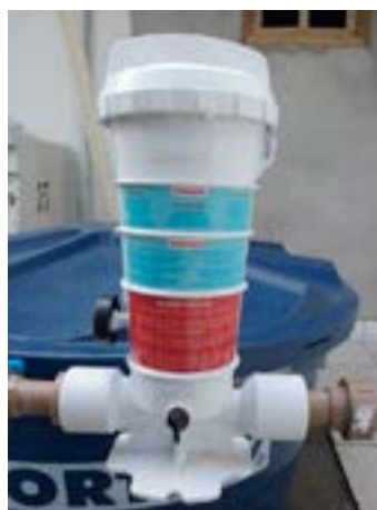
Figura 2 – Sistema para desinfecção por cloro em pastilhas.
