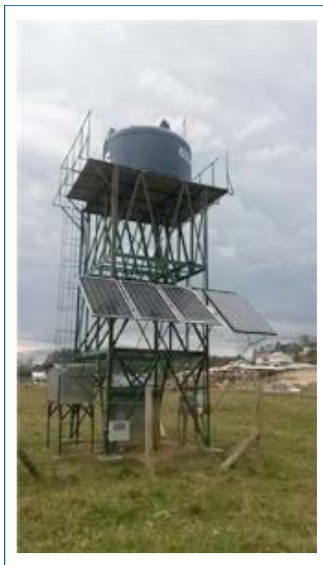
Figura 2 – Instalações do sistema-piloto de filtração em margem.
