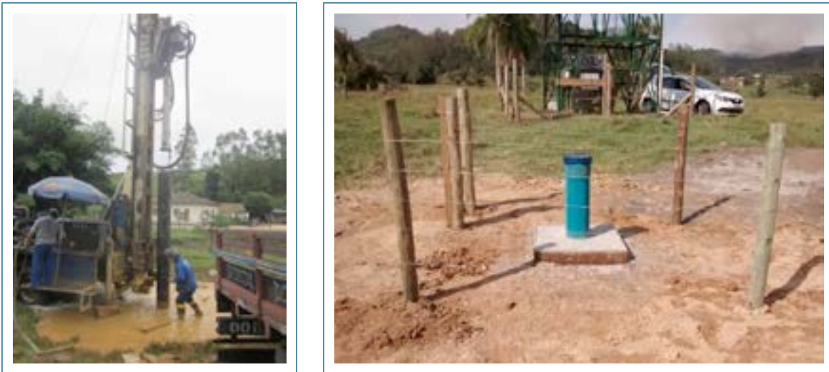
Figura 3 – (a) Procedimento de perfuração do poço tubular. (b) Poço de FM finalizado.
