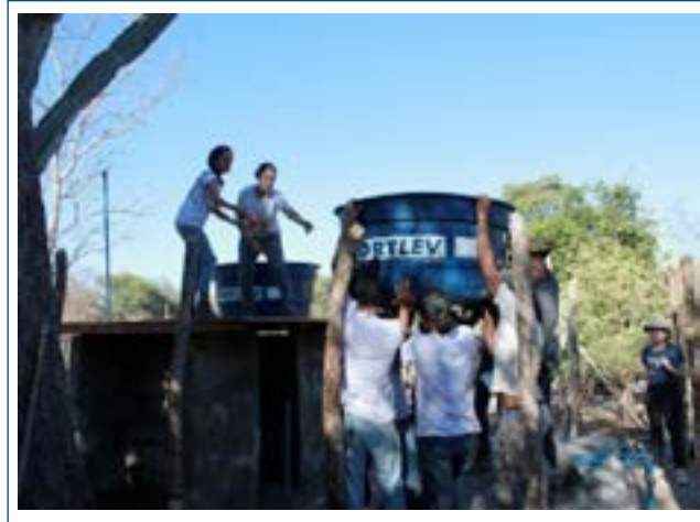
Figura 1 – Instalação dos decantadores do sistema de tratamento de água piloto.
