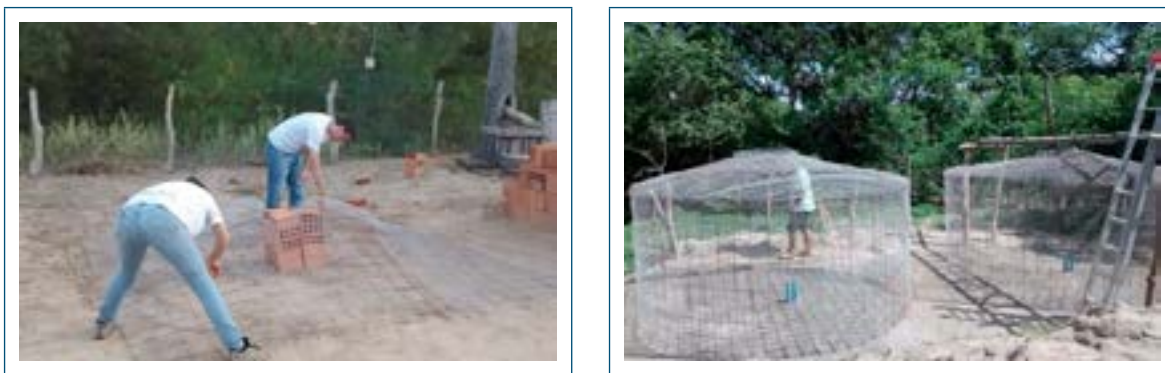
Figura 3 – À esquerda, montagem da armação da cobertura. Direita: armações finalizadas.
