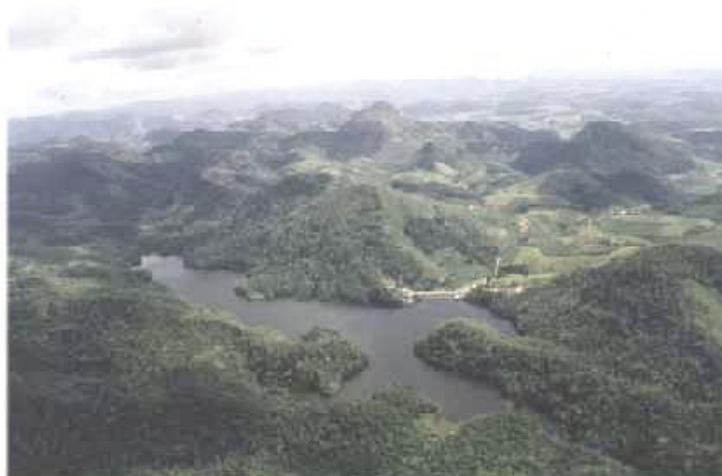
Figura 1 – Vista aérea do reservatório Duas Bocas, destacando o local da barragem
