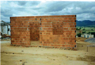
Fig. 07- Alvenaria concluída.
