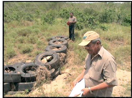
Figura 7. Vista da parte jusante BAPUCOSA 5 mostrando afundamento dos pneus do centro, porém não ocorreu perda de pneus durante o processo de enxurradas de janeiro de 2005. Figura 8. BAPUCOSA 5, sendo avaliado pelos técnicos da FUNASA, em março de 2005.
