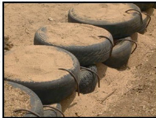
Figura 3. BAPUCOSA 2 com detalhe do preenchimento de areia na ausência de pedras.
