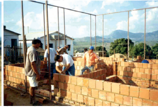
Fig. 06- Execução da alvenaria.
