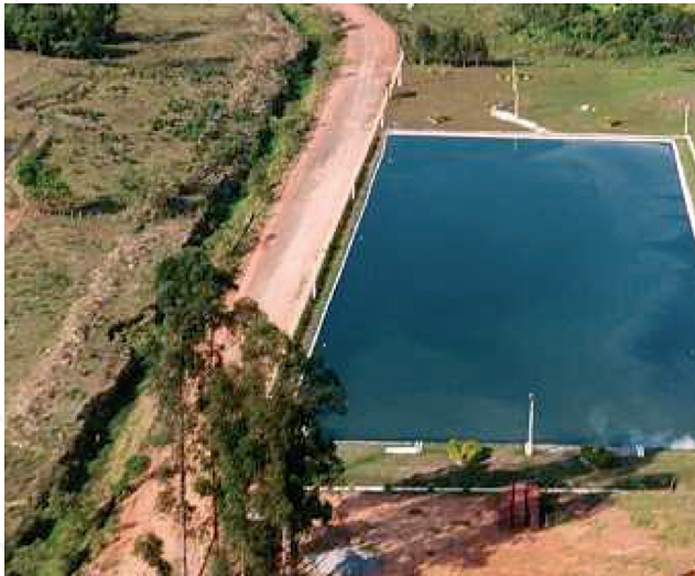
Fotografia da Lagoa em Funcionamento
