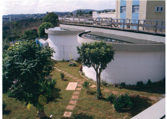
Vista lateral dos decantadores
