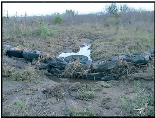
Figura 6. Trecho do BAPUCOSA 3 na calha do riacho após as primeiras chuvas do local, mostrando o “emborcamento” de um único pneu.
