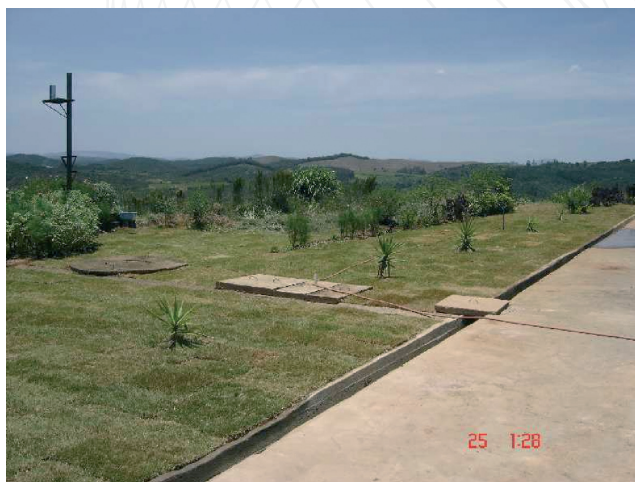
Figura 10 – unidade de tratamento dos efluentes
