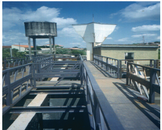
Vista superior dos Floculadores e do Filtro de Areia ao fundo
