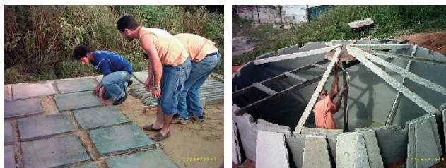
Figuras 1 e 2 – Etapas da construção das cisternas de placas.
