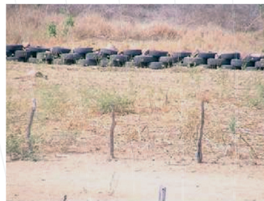
Figura 11. Vista a jusante da distribuição das camadas num trecho do BAPUCOSA 9, onde observa a última camada com pneus médios intercalados com pedras.
