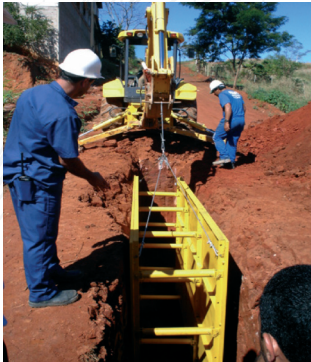
Escoramento Móvel sendo arrastado pela Máquina Retroescavadeira
