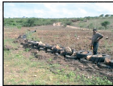
Figura 12. BAPUCOSA 9, em março de 2005, observando restos culturais presos na face montante do barramento.
