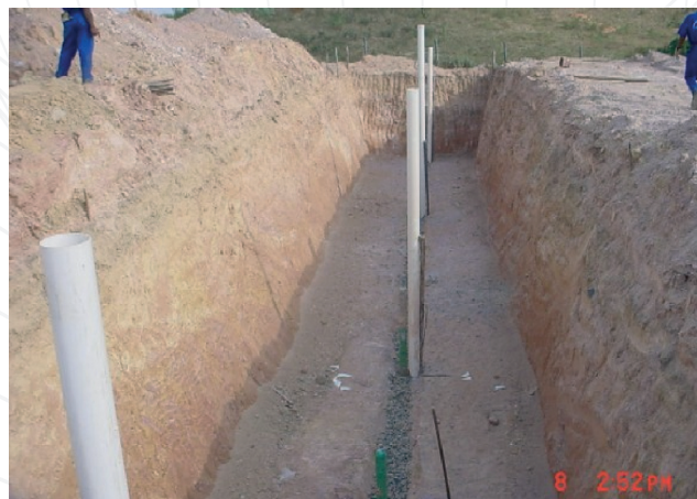
Figura 3 – Abertura da trincheira
