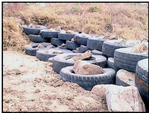
Figura 9. Vista da parte jusante BAPUCOSA 7 mostrando a camada de pneus de proteção contra os impactos da água em momento de transbordamento.
