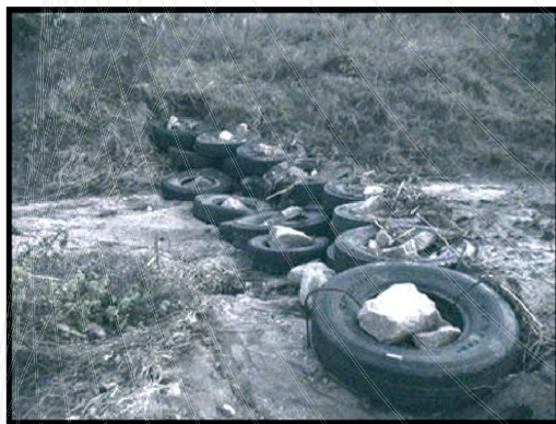
Figura 10. BAPUCOSA 7, após chuvas de janeiro de 2005, apresentando estado impetuoso, sem deformações ou deslocamentos decorrentes dos impactos da correnteza do riacho.
