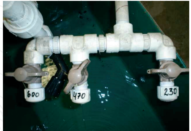
Figura 7. Dosador de flúor de fluxo constante (DFFC) da Citágua.
