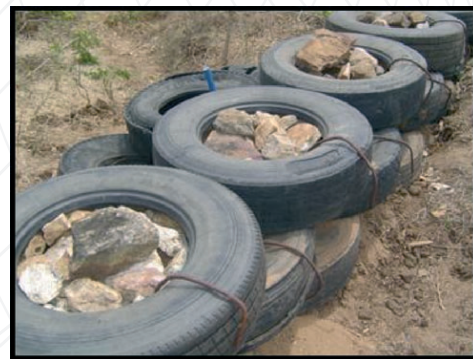
Figura 1 .BAPUCOSA 1, com detalhamento das pontas das varas de ferro virada e pedras dispostas na última camada.
