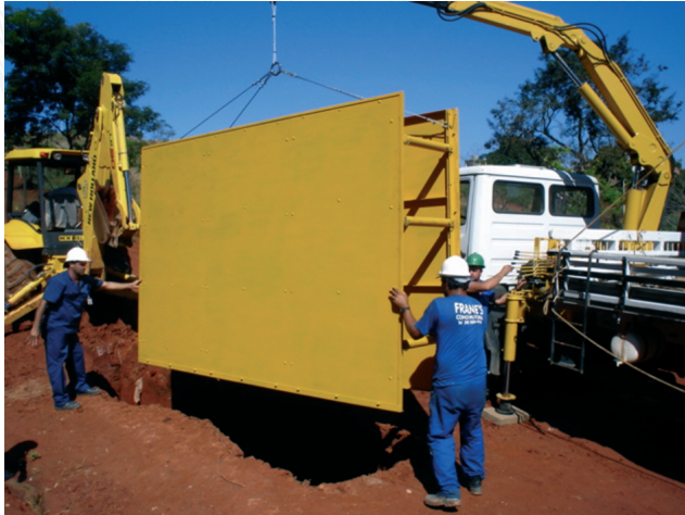
Escoramento Móvel sendo transportado para vala no caminhão muque
