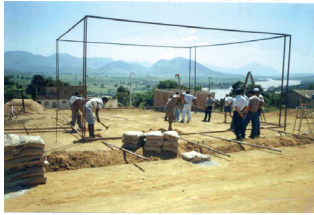
Fig. 05 – Guias em tubos metalon.
