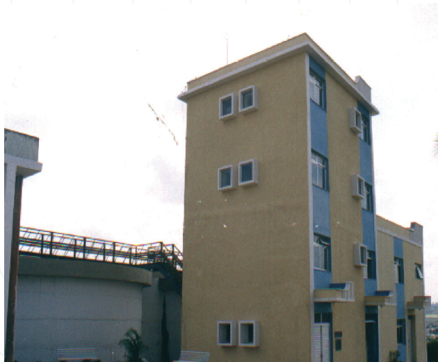
Vista lateral da Casa de Química
