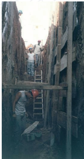
Montagem do Escoramento de Madeira
