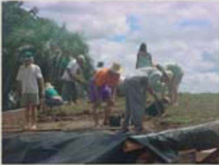
Construção do Telhado Vivo
