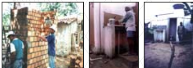
Figura 1 – Construção de banheiros.
