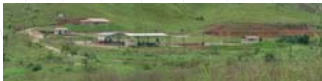
Foto 3. Vista Geral do Sistema Integrado de Destinação Final dos Resíduos Sólidos do Município do Rio Formoso-PE.
