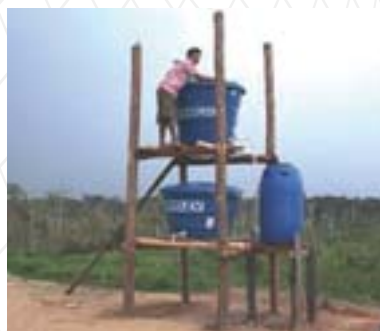
Filtro instalado na aldeia Kulina Degredo
