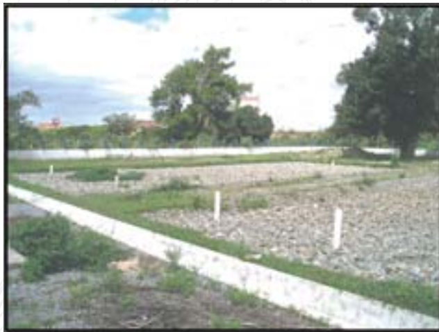
Figura 1 Vista geral da unidade
