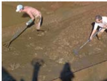
Figura 2: Funcionários utilizam rodos de madeira para auxiliar a remoção de lodo
