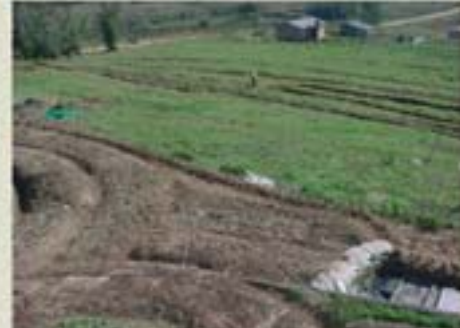
Tratamento de Águas Negras
