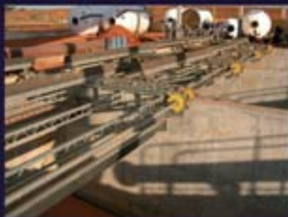
Unidade de polimento de Samambaia em execução
