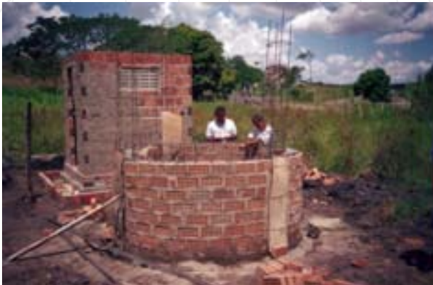
Figura 2 – Poço raso com tijolos perfurados e anéis e pilares de concreto
