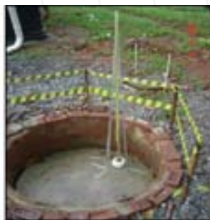
Figura 4.5: Poço de infiltração acabado (detalhe da bóia de leitura de nível).
