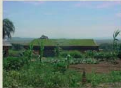
Vista do Telhado Vivo
