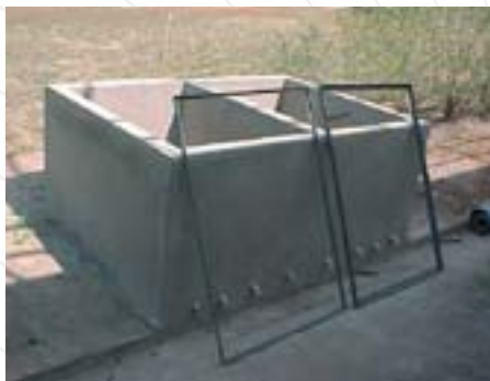
Figura 3: Leito de drenagem pronto, com os tubos de PVC, para saída e coleta da água drenada.
