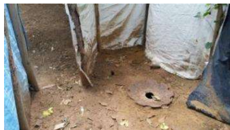
Buraco utilizado para a defecação, protegido por um biombo de plástico.
