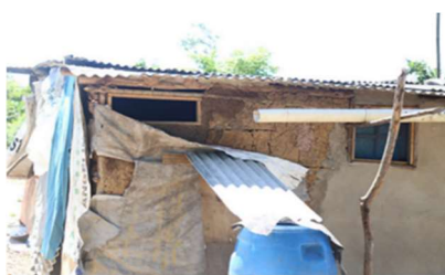
Sistema de captação de água de chuva construído por morador.
