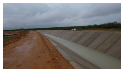
Obras do eixo leste do canal de transposição do rio São Francisco
