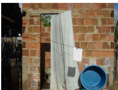
Banheiro em construção.
