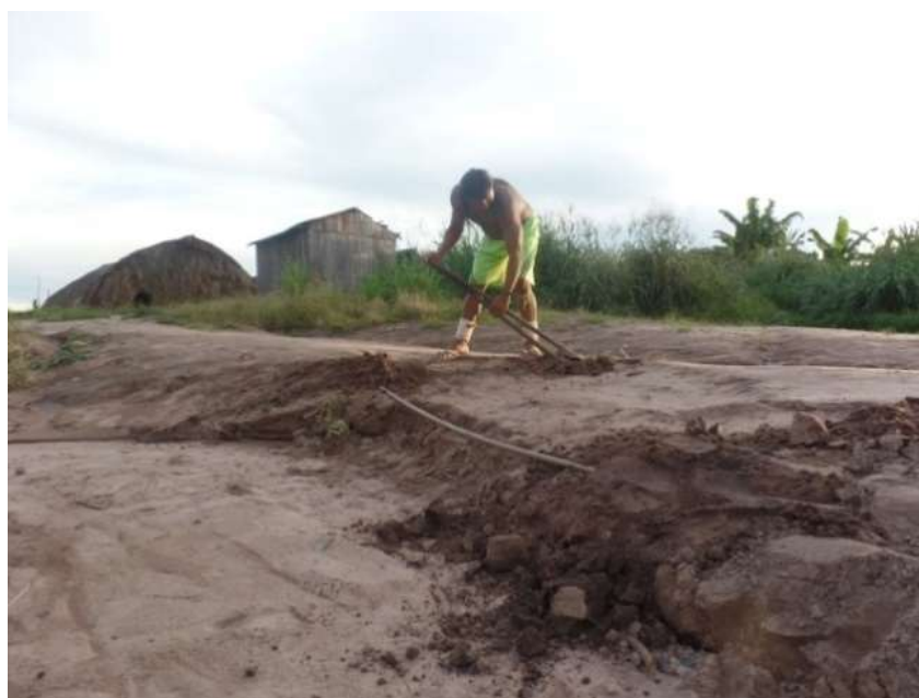
Figura 35 – AISAN realizando o cobrimento do cano de abastecimento exposto.
