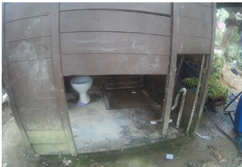
Figura 9 – Banheiro de madeira
