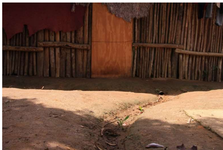
Figura 16 – Instalação de rede para a drenagem pluvial
