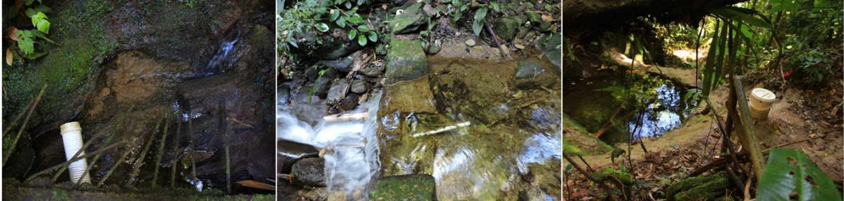
Figura 4 – Pontos de captação Sistema Cacique, Pupunha e Aldo, respectivamente
