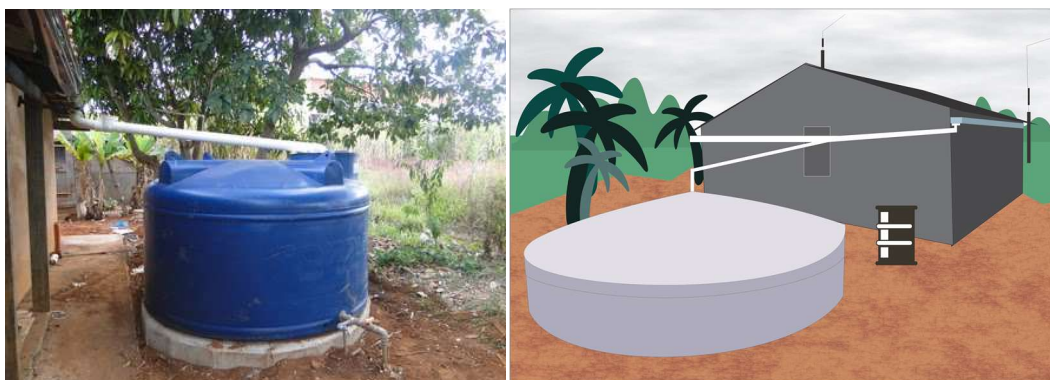
Figura 5.4 Reservatório de água de chuva
