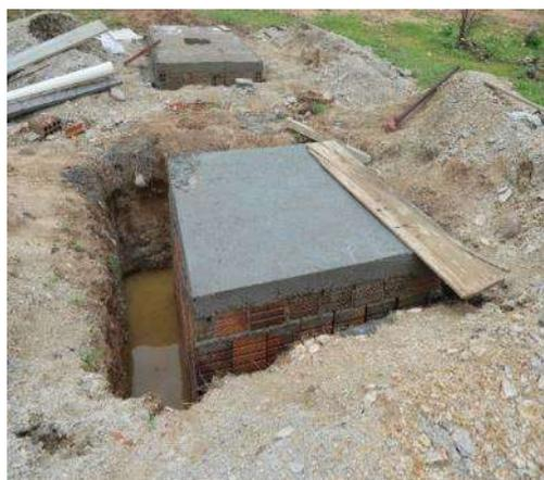
a) Sistema de tanque séptico e sumidouro em uma das casas que estão sendo construídas
