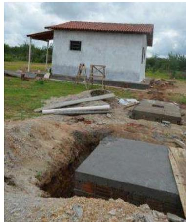
d) Fosse séptica e sumidouro utilizados como destinação final das águas residuárias
