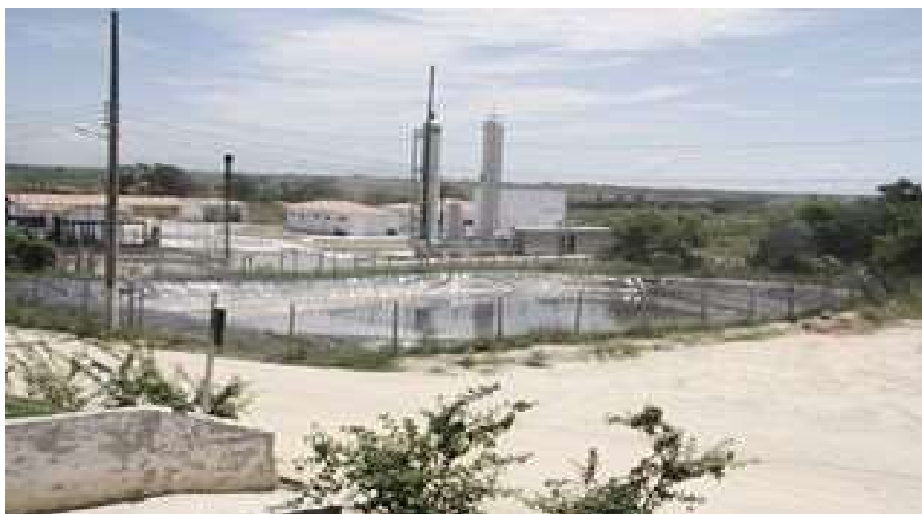
Figura 131– Sistema de coleta de chorume no aterro sanitário
