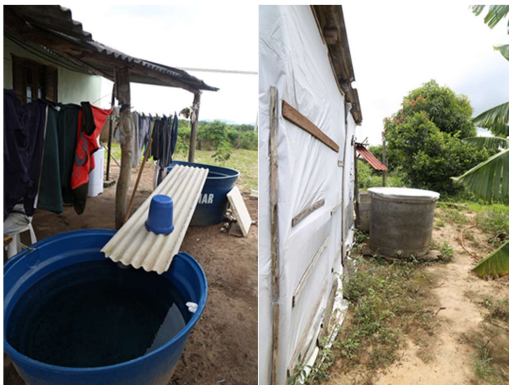
Figura 42 – Captação de água de chuva, utilizando telha de amianto, para conduzir a água do telhado à caixa d' água
