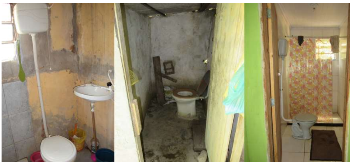
Figura 114 – Imagem de alguns banheiros da comunidade
