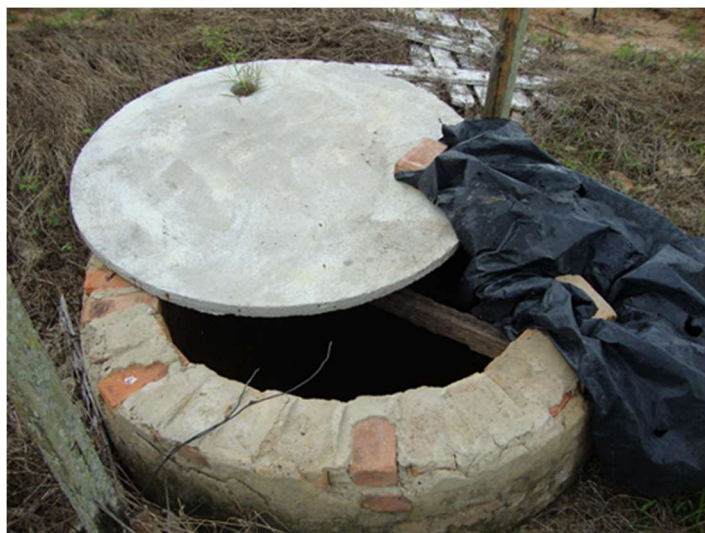
Figura 34 – Poço escavado manualmente, revestido de alvenaria e com tampa de concreto
