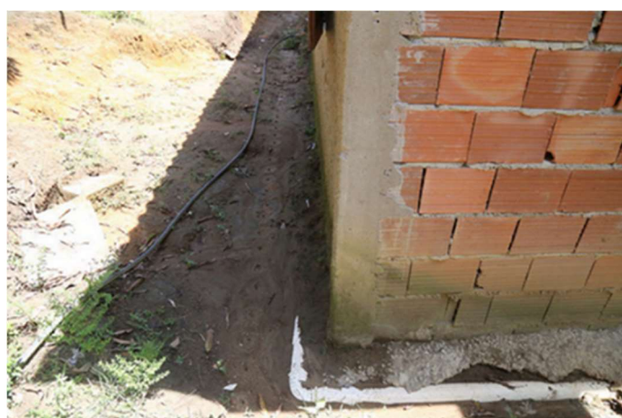
Figura 163 – Proximidade de mangueira utilizada no abastecimento e tubulação destinada ao esgotamento sanitário
