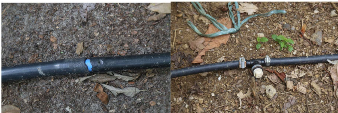
Figura 166 – Emendas das mangueiras do sistema de abastecimento de água
