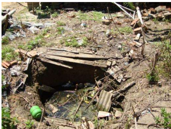
Figura 120 – Esgoto a céu aberto encontrado em outro ponto da comunidade
