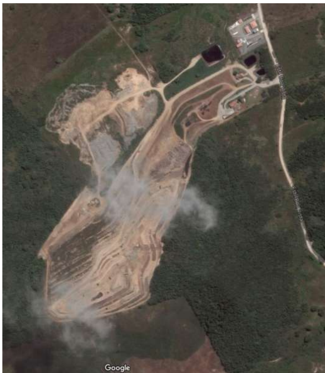
Figura 16 – Aterro sanitário para destinação dos resíduos sólidos de São Pedro da Aldeia
