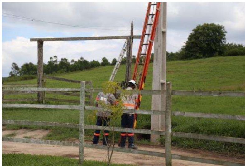
Figura 19 – Instalação da energia elétrica na comunidade
