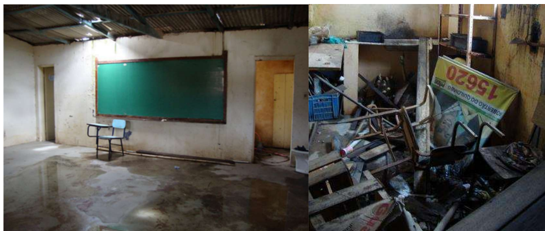
Figura 137 – Área interna da Associação – telhado quebrado, água de chuva no chão, materiais abandonados
