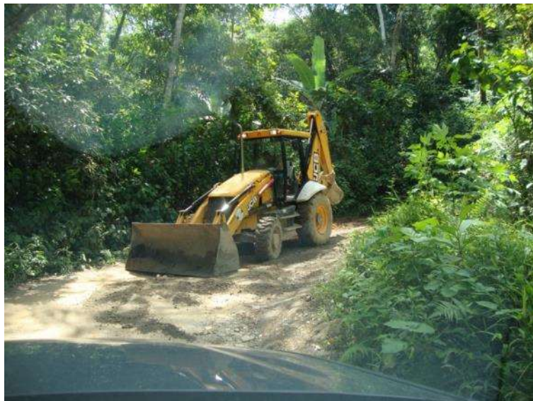
Figura 186 – Trator realizando o recapeamento das vias de acesso
