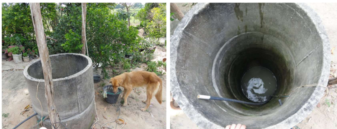
Figura 103 – Poços de água instalados na comunidade, com captação realizada manualmente
