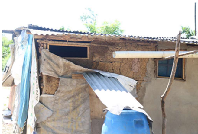
Figura 43 – Captação de água pluvial, utilizando tubulação de PVC e telha de amianto
