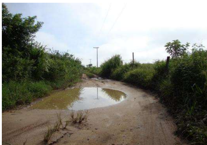
Figura 70 – Empoçamento de água em área interna do assentamento
