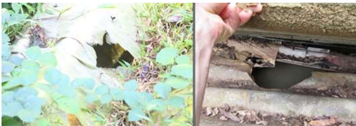
Figura 172 – Duas fossas cheias, com presença de mosquito e/ou mau cheiro
