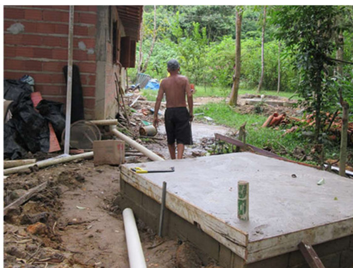
Figura 171 – Fossa em processo de construção
