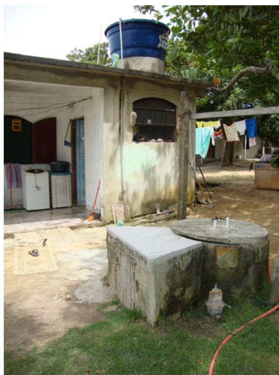
Figura 104 – Poço instalado em uma residência cuja água é bombeada por meio de bomba elétrica para a caixa d'água localizada em cima do telhado
