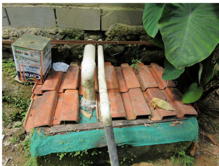
Figura 170 – Fossa recoberta com telhas cerâmicas
