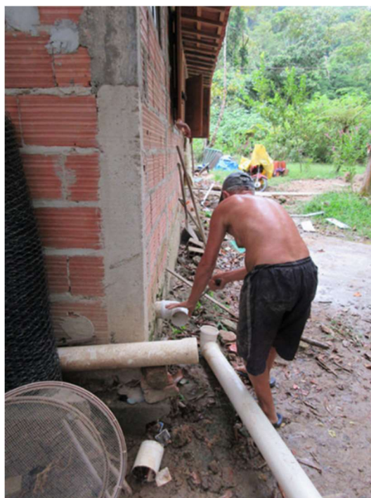
Figura 195 – Morador construindo a solução de esgotamento sanitário
