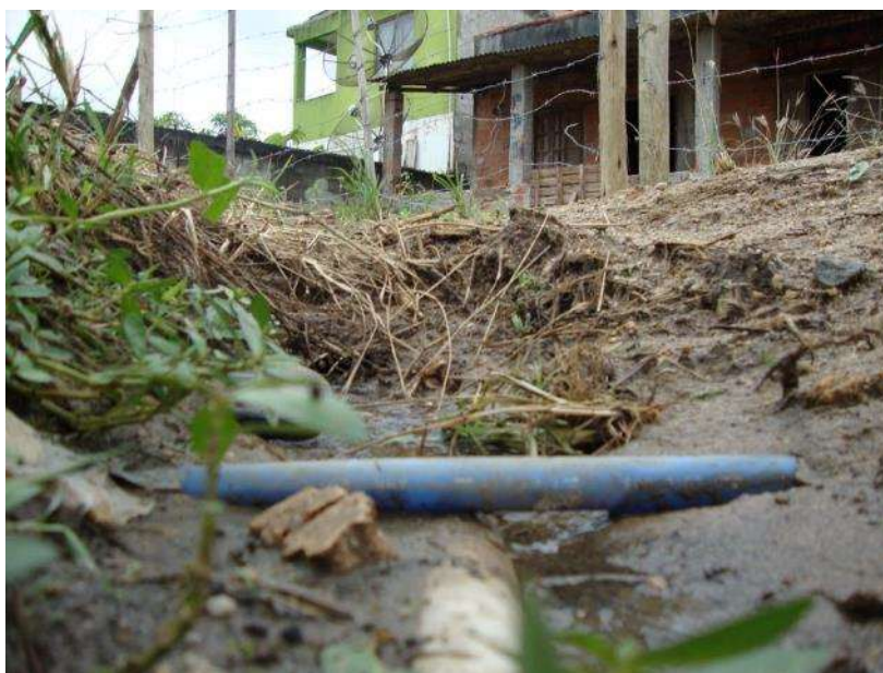
Figura 122 – Cruzamento de tubulações de água e esgoto
