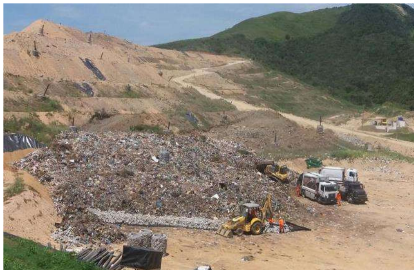
Figura 66 – Aterro sanitário Dois Arcos, no Município de São Pedro da Aldeia
