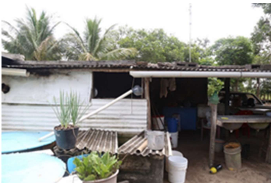
Figura 40 – Captação de água pluvial, por meio de calha feita de tubo PVC
