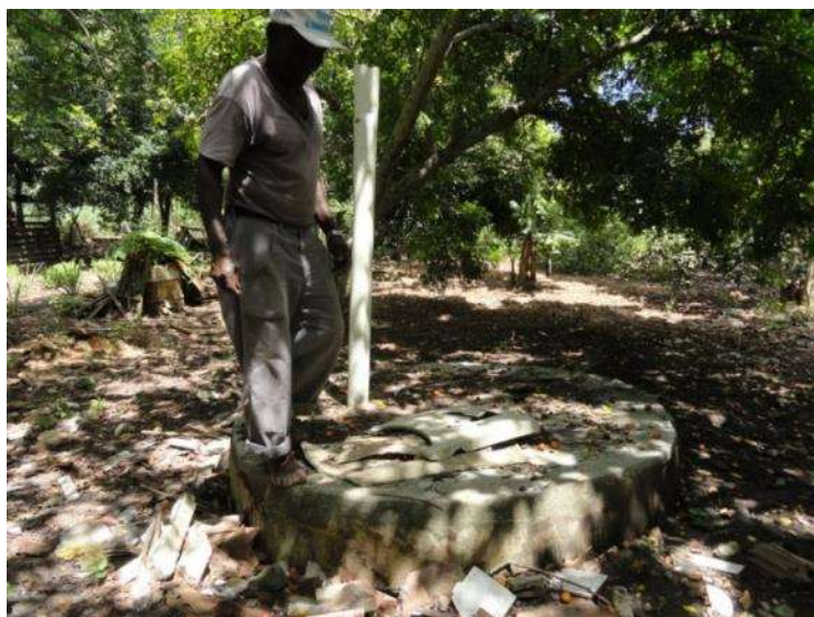
Figura 124 – Fossa destinada para a esgotos da criação de porcos
