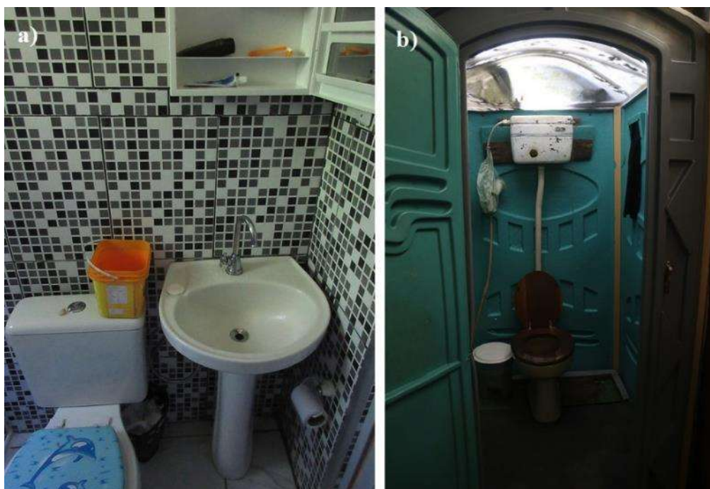
Figura 169 – a) Banheiro de um dos moradores, em boas condições de uso; b) Banheiro de um morador, construído a partir de um banheiro químico
