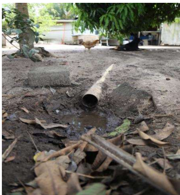
Figura 56 – Disposição de águas cinzas no solo
