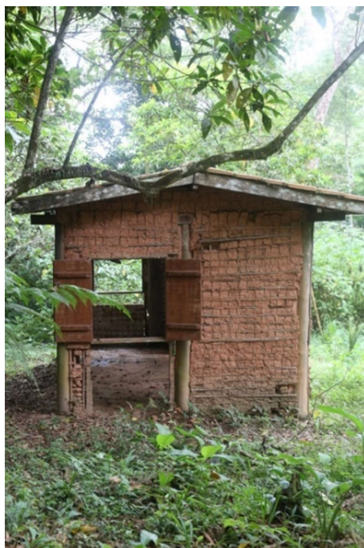
Figura 154 – Centro de artesanato construído na entrada da comunidade, atualmente abandonado
