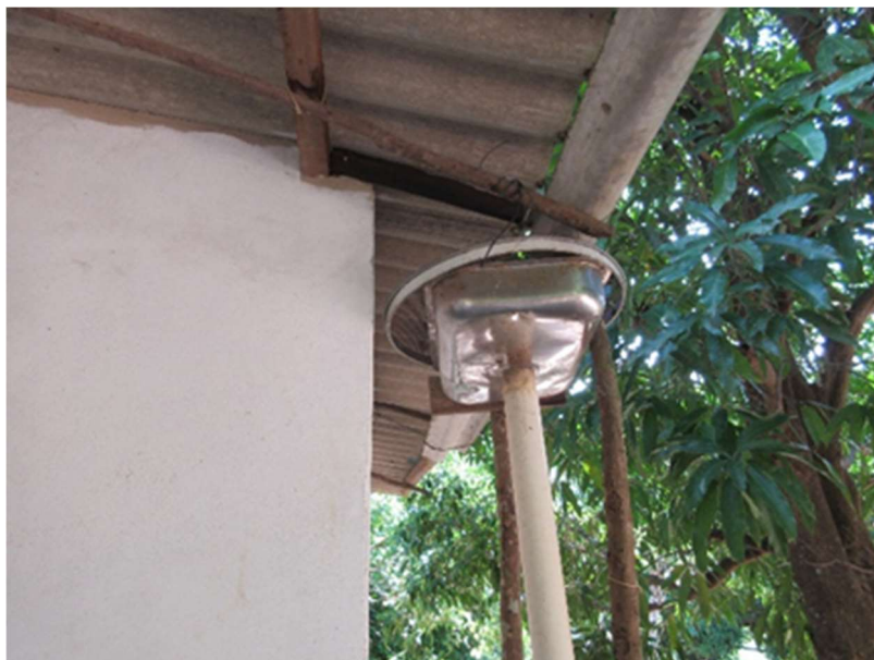
Figura 106 – Sistema de captação de água de chuva elaborado por um morador
