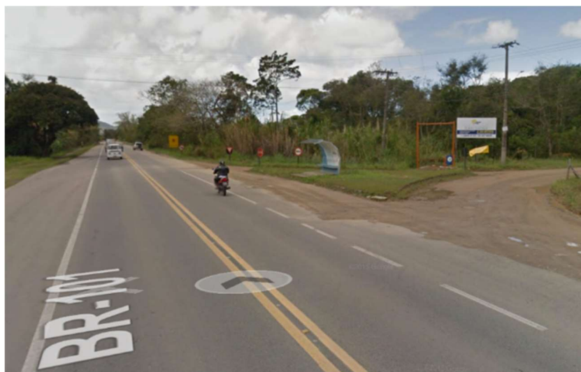
Figura 140 – Entrada da estrada da comunidade quilombola Caçandoca
