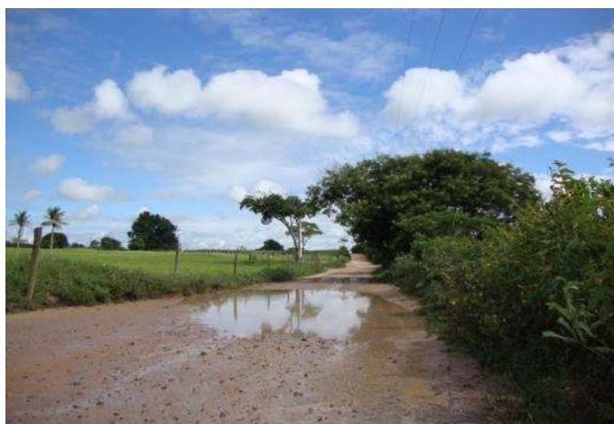
Figura 69 – Empoçamento de água na estrada de acesso à comunidade
