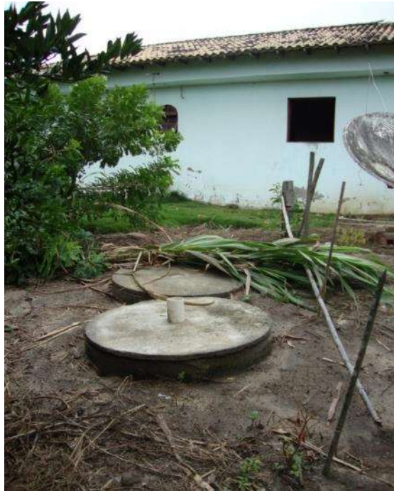
Figura 117 – Fossa e filtro localizados em uma das casas
