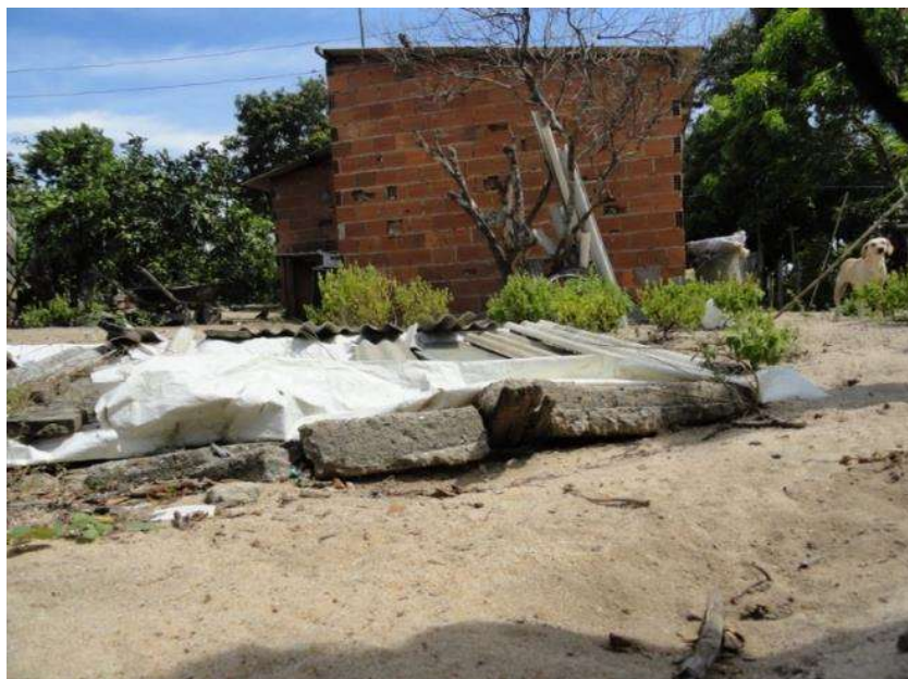
Figura 123 – Fossa da família que utiliza água do poço localizado atrás do cachorro na foto
