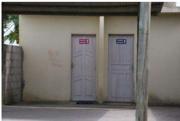
Figura 52 – Banheiro para uso dos fiéis na igreja local
