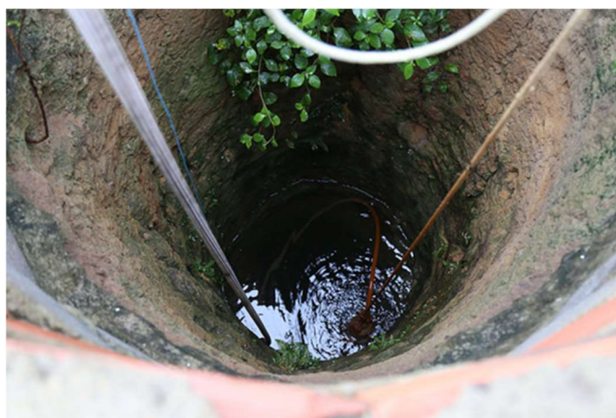
Figura 36 – Captação de água do poço, utilizando bomba elétrica
