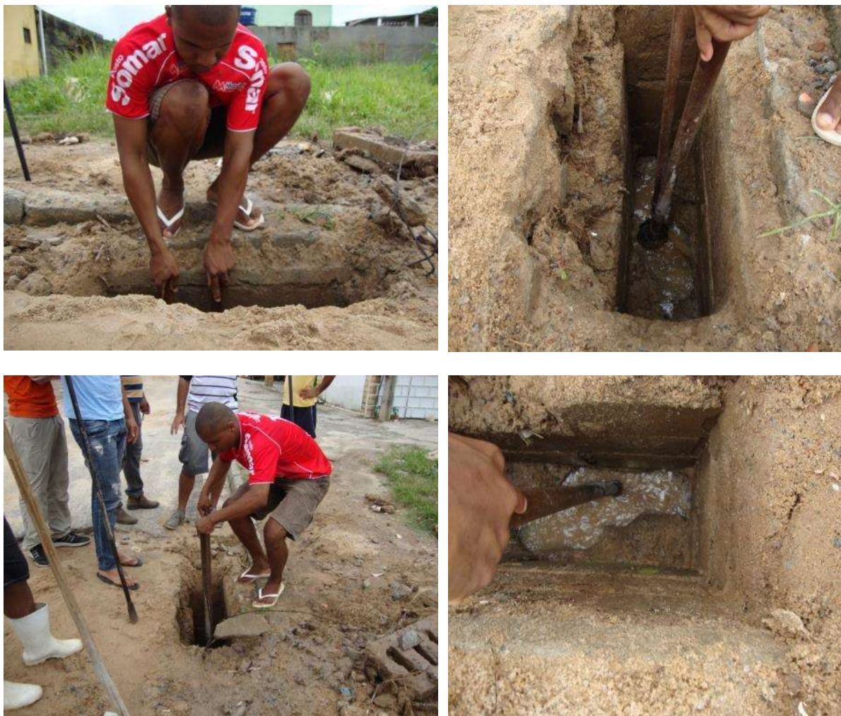
Figura 134 – Manutenção da rede de drenagem, pelos moradores
