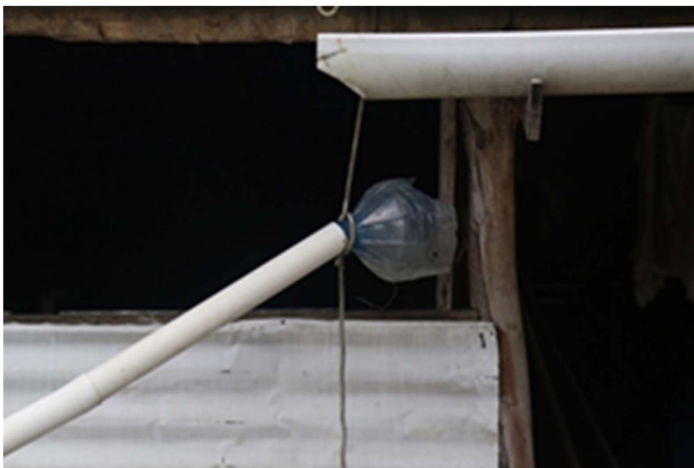
Figura 41 – Conexão de tubulação, feita de garrafa plástica e corda
