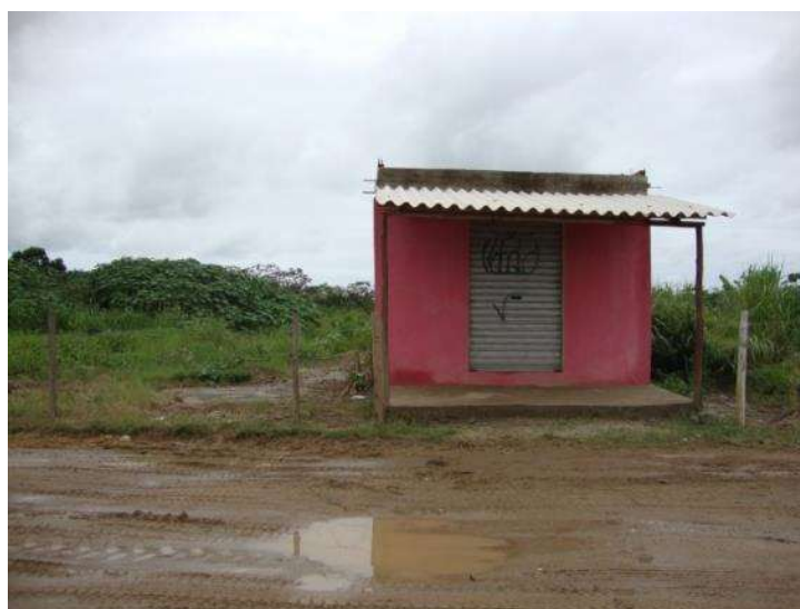
Figura 133 – Local de lançamento das águas pluviais coletadas
