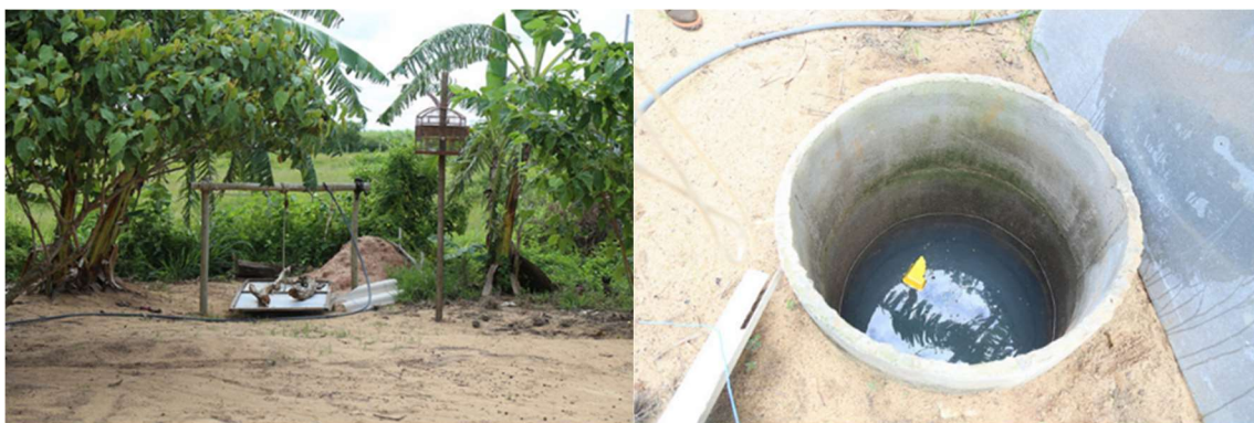
Figura 33 – a) Poço escavado manualmente tampado com uma placa de alumínio b) Mesmo poço destampado, constituído por manilha
