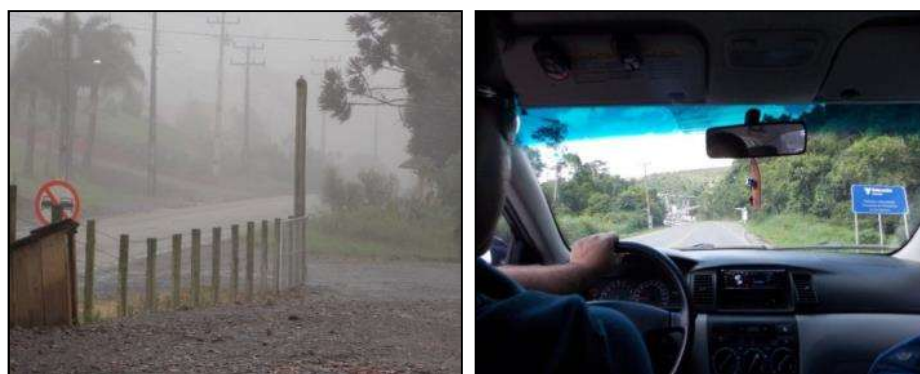
Figura 33 – Imagens da rodovia SC-281, em Nova Alemanha
