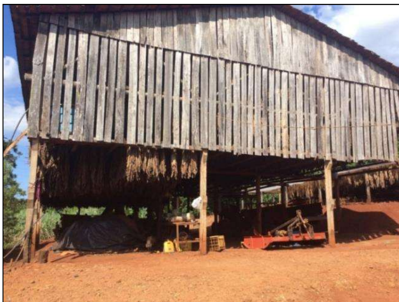
Figura 14 – Galpão para secagem do fumo
