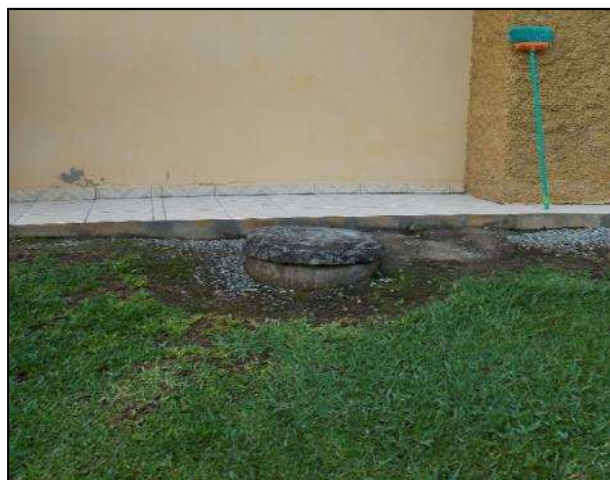
Figura 44 – Fossa absorvente de uma residência e açude que recebe o esgoto da cozinha e da área de serviço
