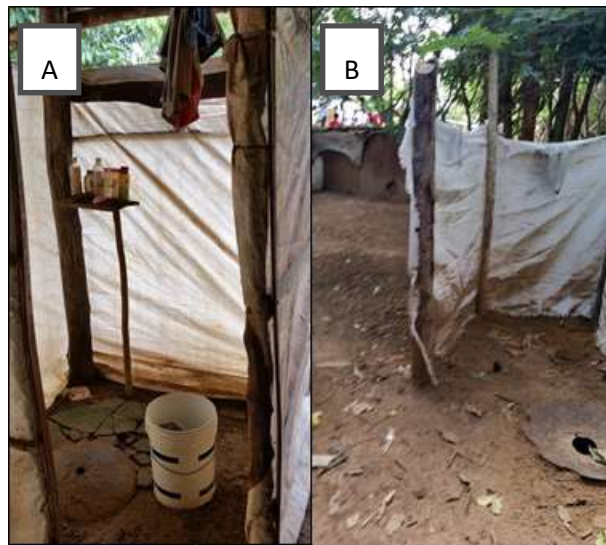
Figura 112 – A: Local utilizado para tomar banho de balde. B: Fossa seca
