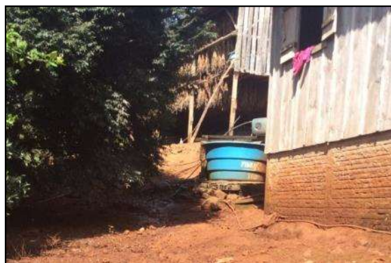
Figura 18 – Caixa d'água com bomba para conduzir a água para o reservatório
