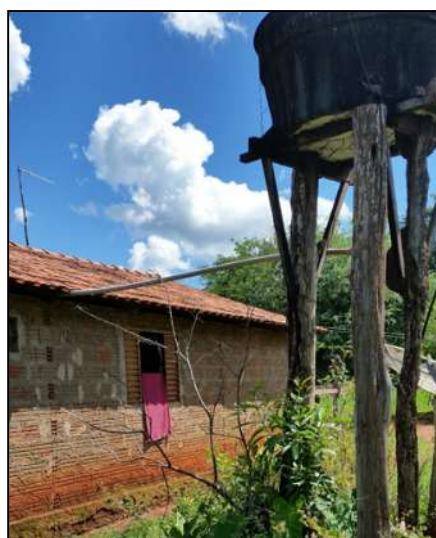
Figura 108 – Caixa d'água de morador do Assentamento Pontal do Buriti
