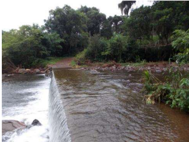
Figura 62 – Barragem no rio Faxinalzinho
