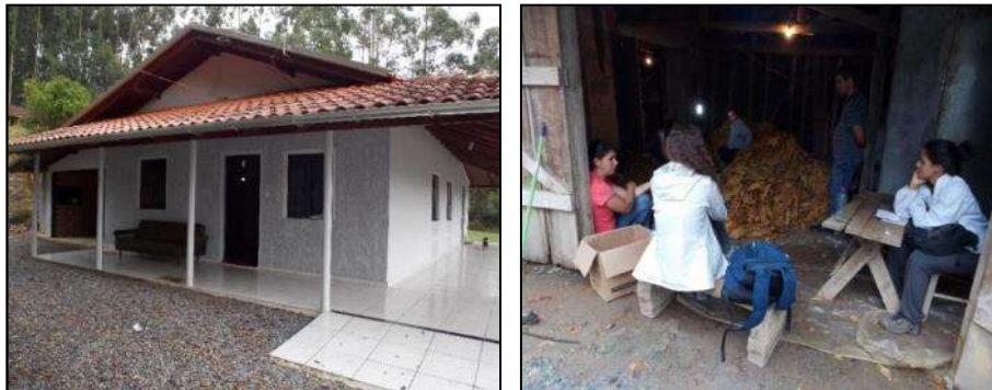
Figura 35 – (a) Casa nova em alvenaria; (b) Antiga residência de madeira, usada como galpão para armazenamento de fumo
