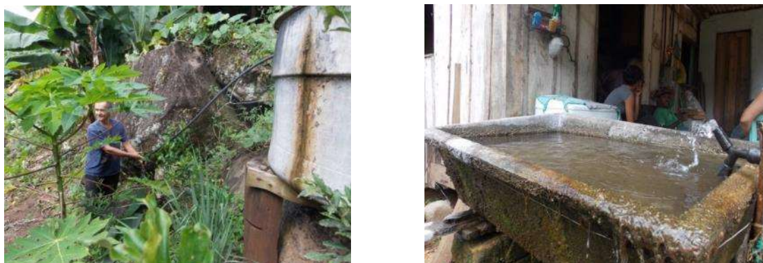
Figura 75 – À esquerda, domicílio com caixa d'água, destaque para morador segurando o ladrão; à direita, água corrente chegando diretamente na torneira
