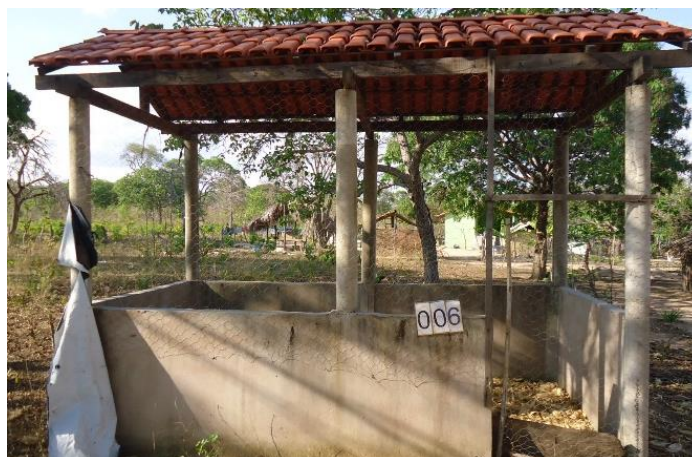
Figura 5. Galinheiro depois da restauração
