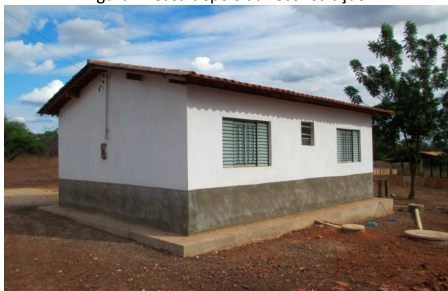
Figura 7. Casa depois da reconstrução
