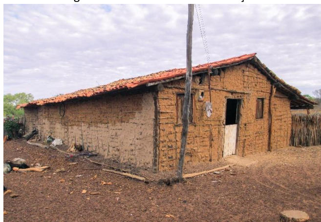
Figura 6. Casa antes da reconstrução
