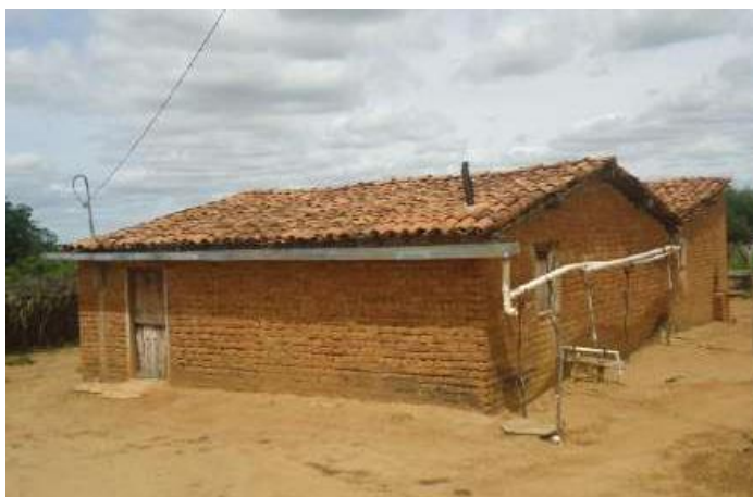
Figura 2. Casa antes da restauração
